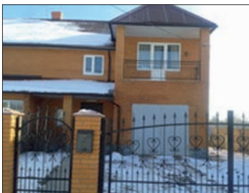
Глеваха полдома, 120 кв.м. отдельный вход, хорошее состояние, 3 спальни, гостиная-столовая, 2 санузла, ванная. Гараж, ухоженный участок на 6 сотках, газон. Хорошие соседи, новая улица. ☎ (95) 6487066, моб., Вита
