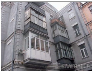
М. "Университет" 2-к. Царский дом после реконструкции (ж/б перекрытия) в самом центре Киева. Квартира под ремонт, фасадный вход в парадное, окна во двор! Бесплатная парковка во дворе. ☎ (50) 3105064, моб.
