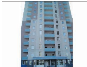
Деснянский р-н, Градинская ул. 7, офис 107.1 кв.м, 24/24-эт. дома, Н/ф, (творческая мастерская). После строителей. Н=3м, стеклянный купол, окна м/п, помещение подготовлено к отделочным работам. Рядом троллейбусная линия, 69000у.е. Без комиссий! ☎ (95) 7575333
