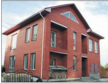
Лисянська 13, 3-этажный дом 2011г., 305 кв.м, высота потолка 3 метра, кирпич, перекрытия железобетонные. Расположен в охраняемом коттеджном городке состоящем из 8 домов, 6 комнат, 3 просторных санузлов с окнами, в подвале есть возможность оборудовать спортзал, 335000у.е. торг. ☎ (44) 2202922, (50) 3859914, Сергей
